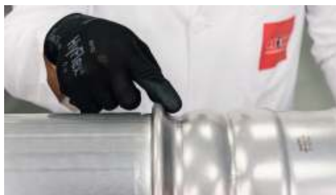
Рис. 36. Визуальный осмотр места прессования Oversize.
